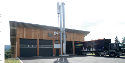
Satellitenheizkraftwerk auf Basis von Biomasse im Ortsteil Schönbrunn im oberfränkischen Wunsiedel
